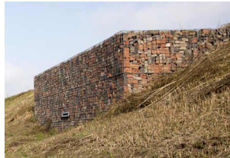
Vleermuisbunker in nieuw grondlichaam
