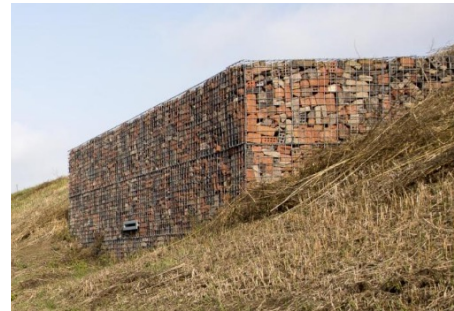
Vleermuiskelder in nieuw grondlichaam
